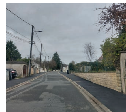
Rue de Beauregard : réfection des trottoirs.
