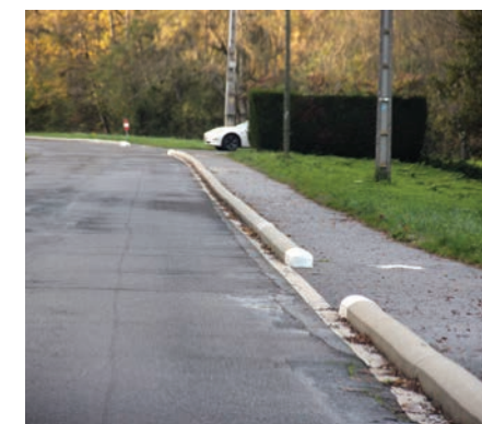
Rues de la Perrée, du Lavoir et de la Roquille : mise en place de bordures séparatives entre le cheminement piétons et la route.
