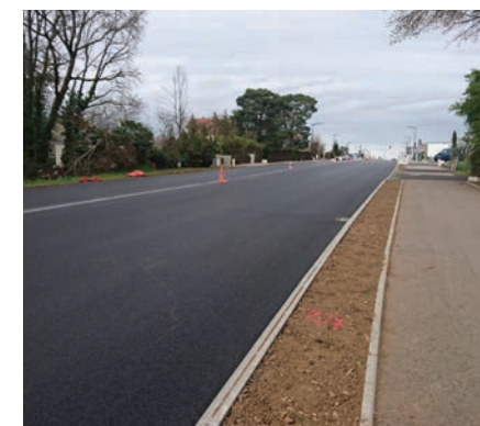
RD 910, du passage à niveau au carrefour de La Folie : création d'une voie dédiée piétons/cyclistes & sécurisation du carrefour pour tous les usagers.
