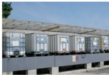
Stockage de solvant de lavage
